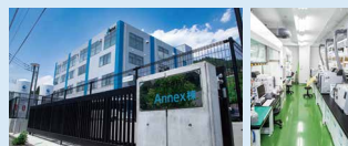
Annex棟(山梨県上野原市) 2020年9月建設 1階にクリーンルーム、2階に分析室、3階に事務所、4階に社員食堂がある管理棟
