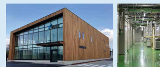
南アルプス事業所(山梨県南アルプス市) 2025年3月建設 新規エッチング材料等の 大規模な製造拠点
